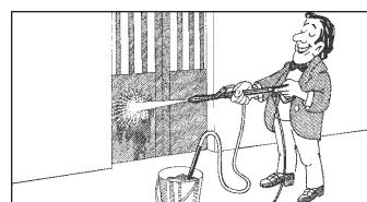
Sablage de restes de peintures, de surfaces rouillées et de façades. Lance de sablage avec dispositif d'aspiration, tuyau flexible PVC de 3 m
